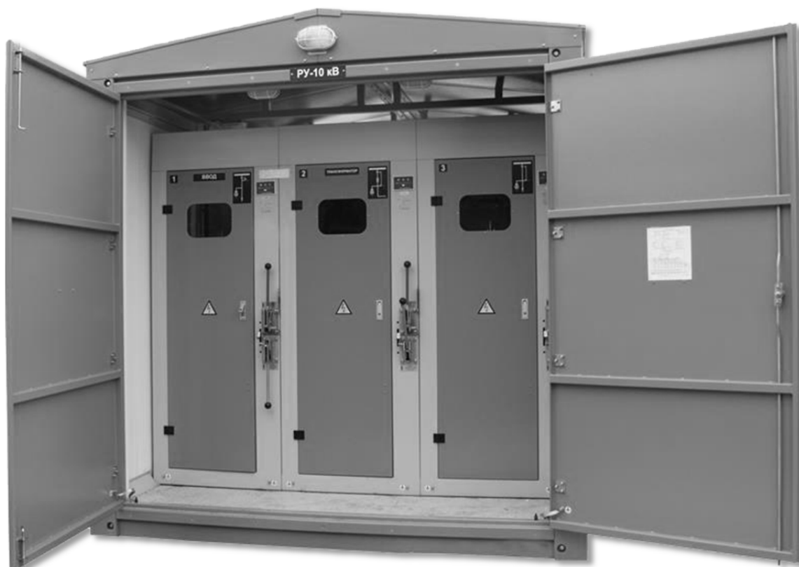
Рисунок 3.2.2 Отсек распределительного устройства высокого напряжения
