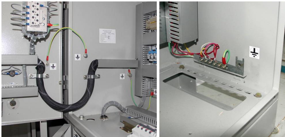
Рисунок 9 Знаки заземления
