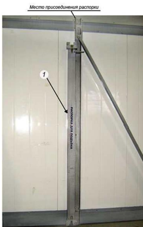
Рисунок 23 Расположение подъемной распорки на блоке
