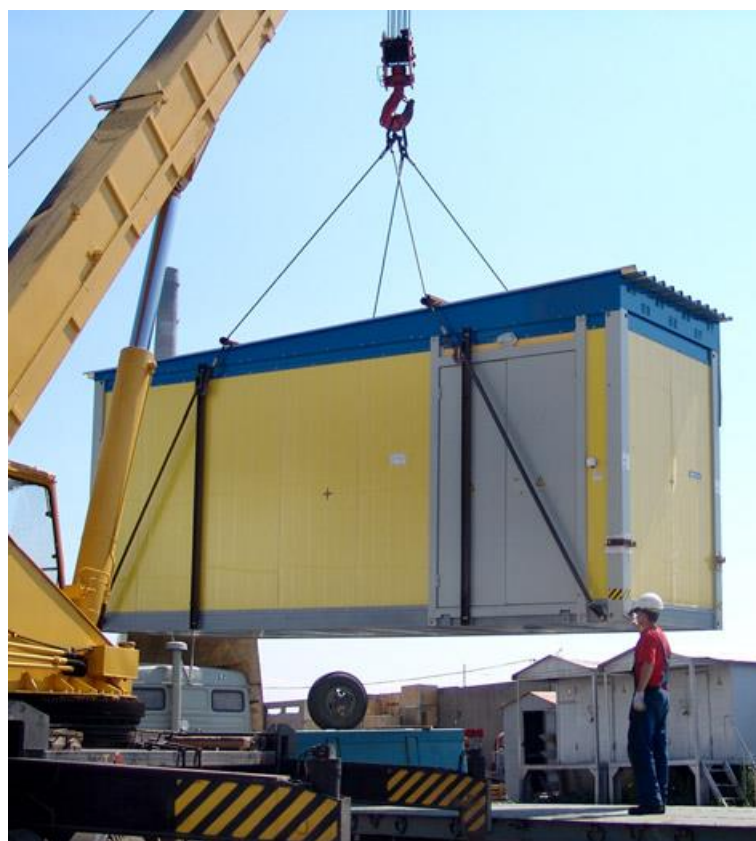
Рисунок 21 Погрузочно-разгрузочные работы КРУ-БМ
