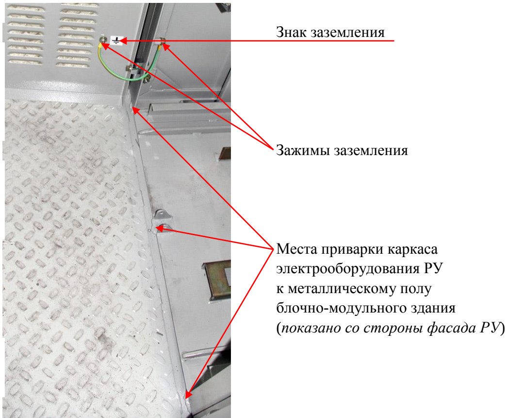
Рисунок 10 Места приварки каркаса
