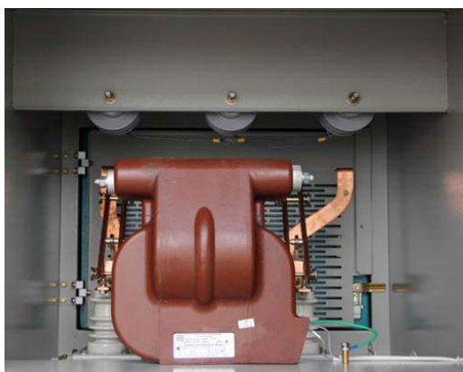
Рисунок 3 – Отсек высоковольтного разъединителя ЯКНО
