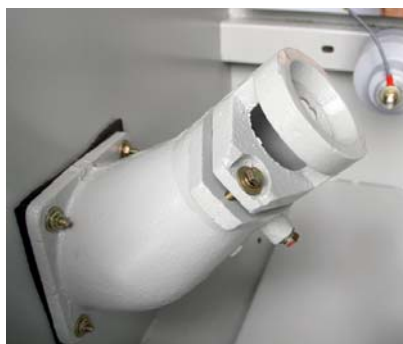
Рисунок 5 – Кабельный ввод герметичный (муфта)
