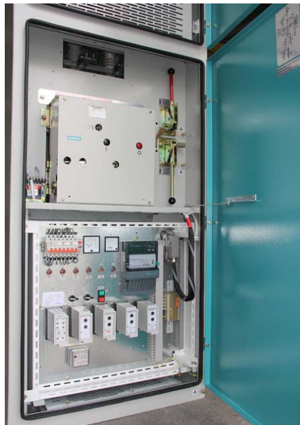
Рисунок 6 – Отсек управления ЯКНО
